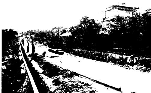
水道、瓦斯、電気地下埋設工事
