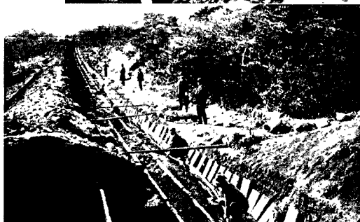
下水工事（ヒューム管埋設）
