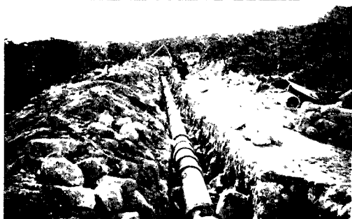
水道、瓦斯、電気地下埋設工事
