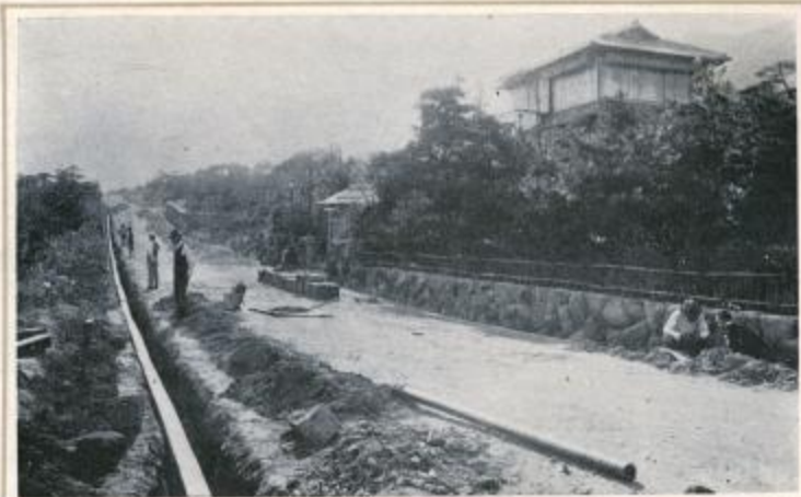
水道、瓦斯、電氣地下埋設工事
