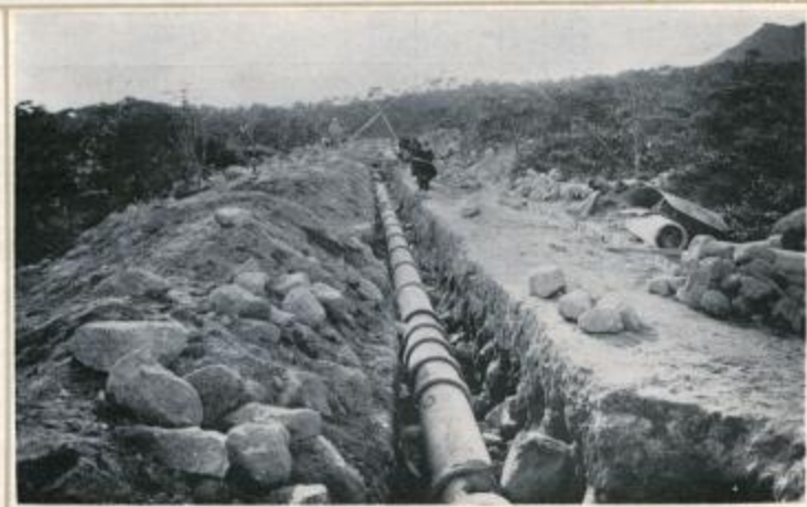
下水工事(ヒューム管埋設)
