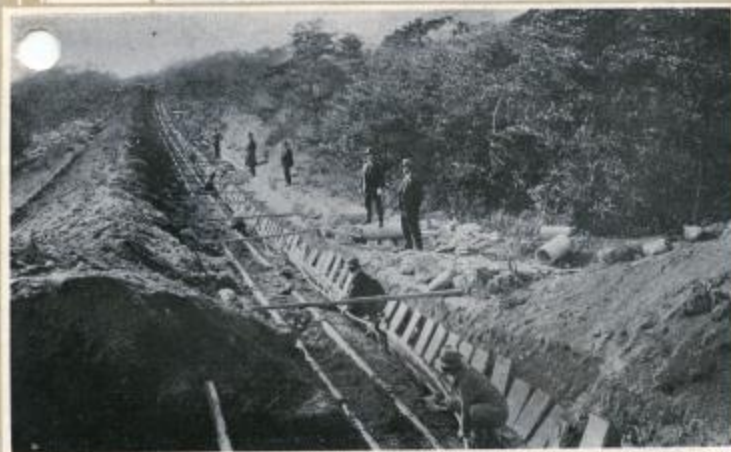
下水工事(ヒューム管埋設)
